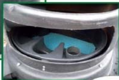
Cuve aérienne verticale de récupération d'eau de pluie
